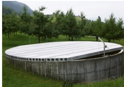
Abb. 2: Spannbeton-Holelemente (Quelle: Kohli AG)
