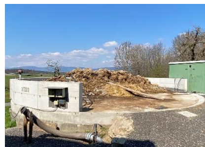
Abb. 5: Betonabdeckung mit Mistlager Achtung Statik prüfen! (Quelle: Arnold & Partner AG)
