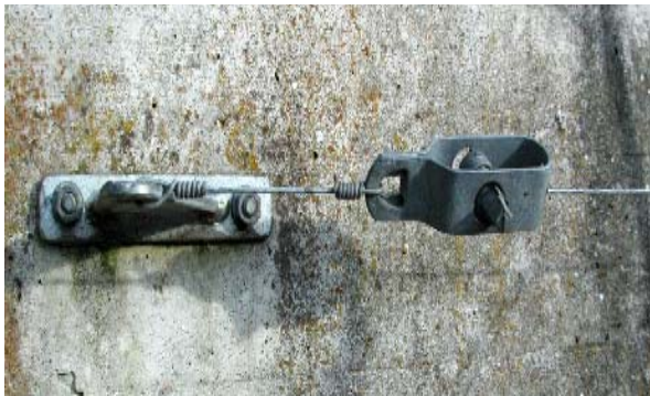
Links: Solide Eisenbefestigung mit Spanner.
